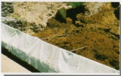
④ 土砂詰め(栗石詰め)
