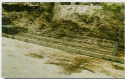
② かご枠設置
