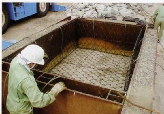
① 組立・型枠設置
