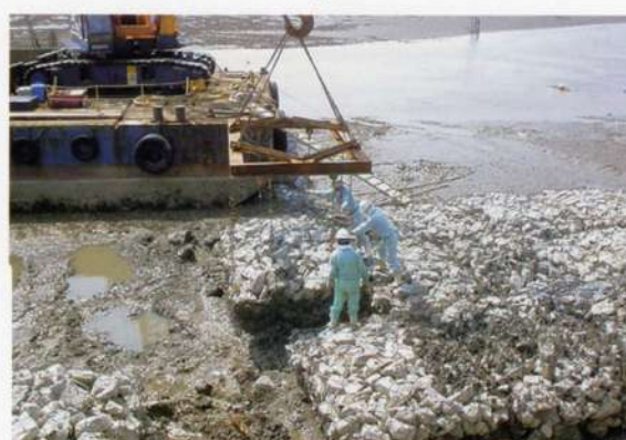
③ 据付け（吊り施工）
