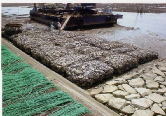
④ 敷設完了
