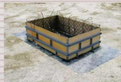
③型枠の取付
