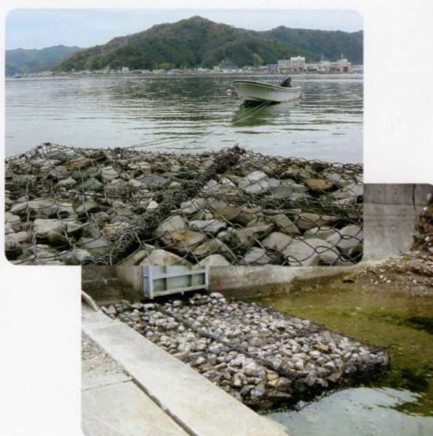
高知県 いの土木事務所
