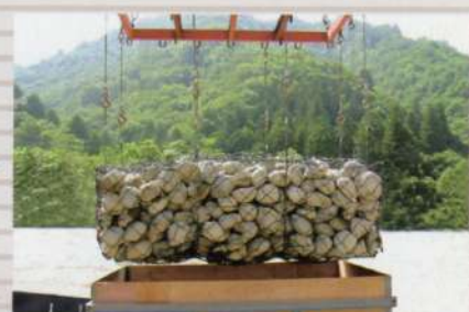
⑥吊り上げ・転置
