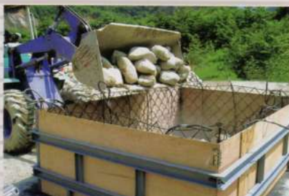
④中詰材の投入
