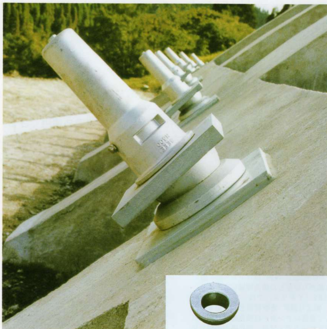
(建設省 宮崎10号四家地区防災)
