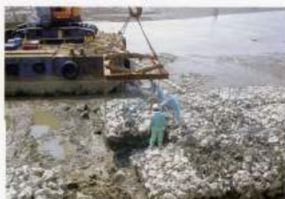
③ 据付け (吊り施工)
