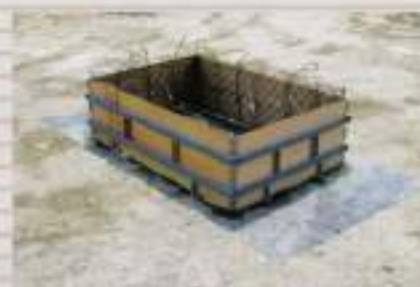
③型枠の取付
