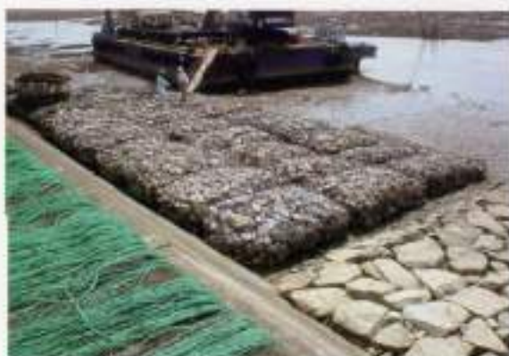
④ 敷設完了
