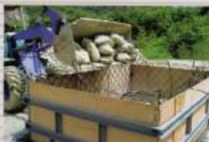
④中詰材の投入
