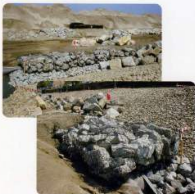
宮崎県 中部港湾事務所
