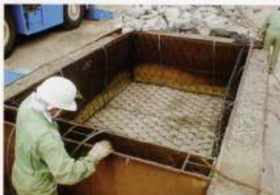
① 組立・型枠設置
