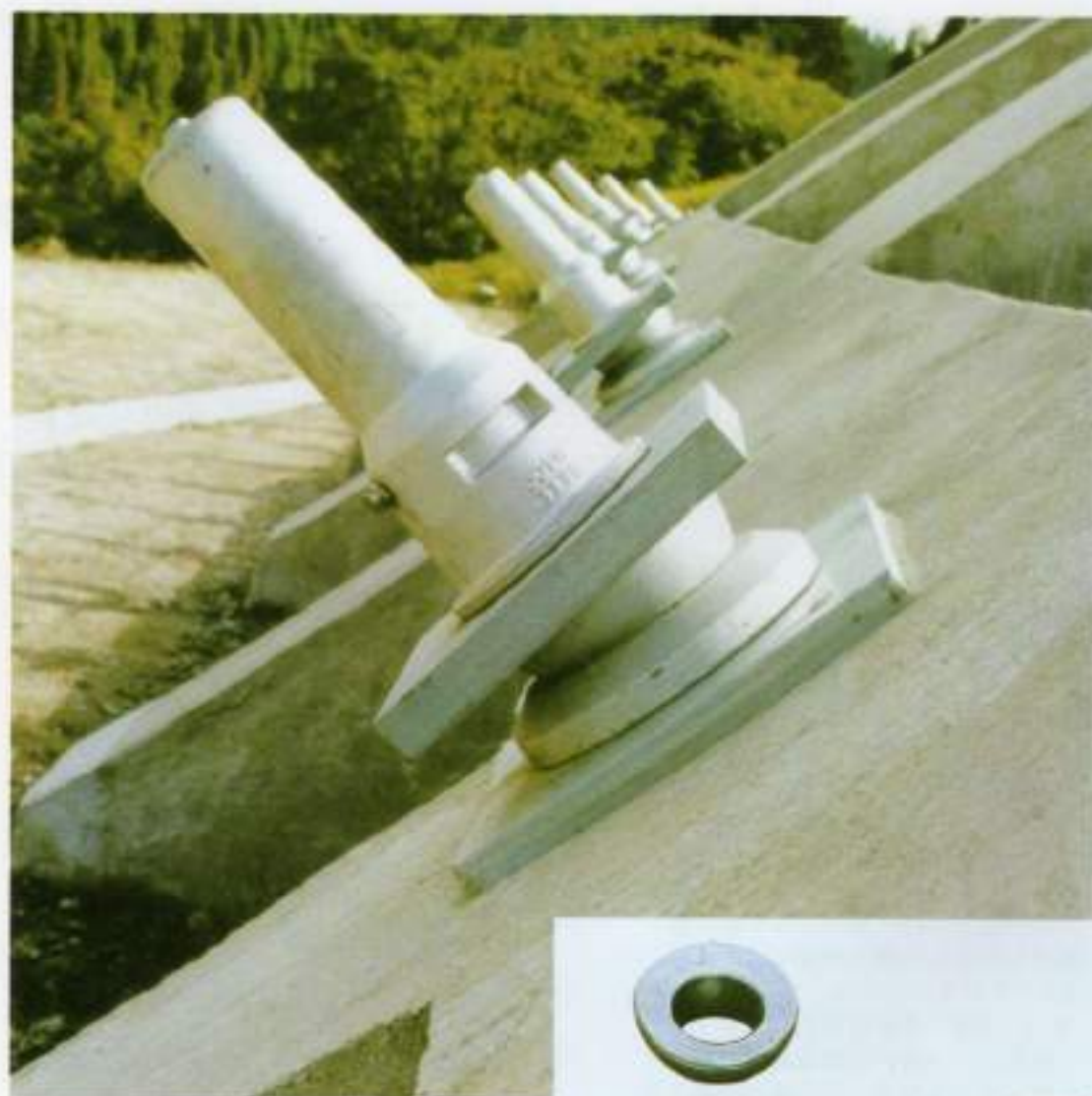
(建設省 宮崎10号四家地区防災)
