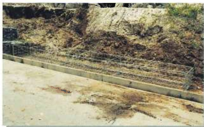
②かご枠設置
