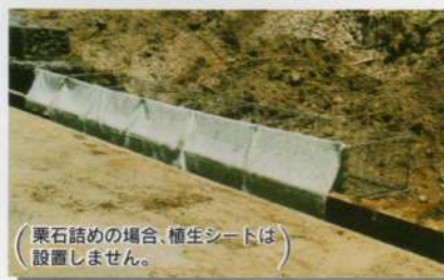
③ 植生シート設置
