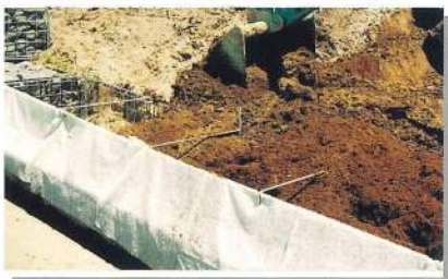
④土砂詰め(栗石詰め)
