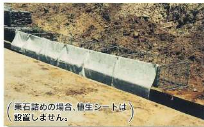
③植生シート設置
