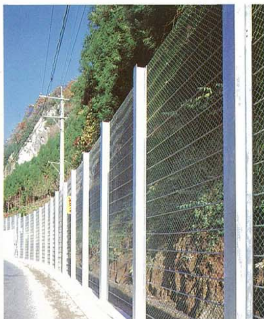
落石防止柵(ストーンガード)
